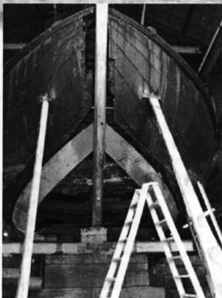
De blazer TX 33 in de loods van de oude Rijkswerf in Den Helder. Inmiddels zijn de voorsteven en de voorste delen van beide kimgangen geplaatst.
